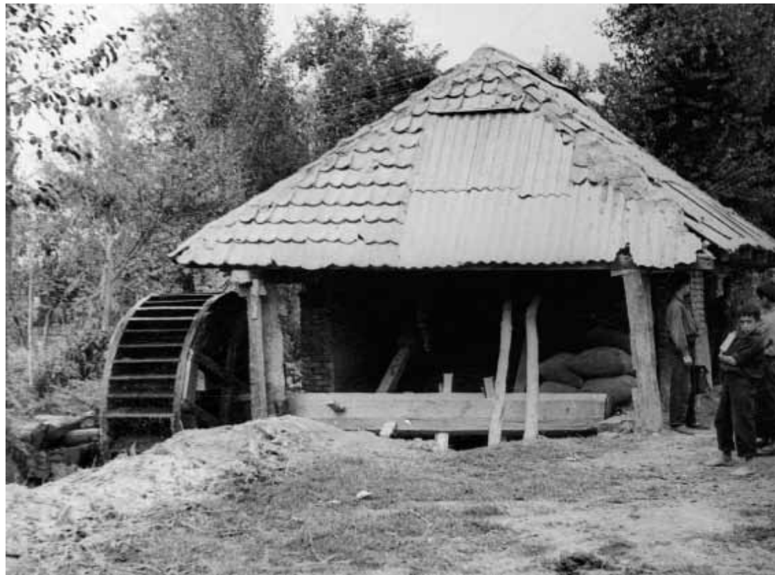
Чистка риса при помощи водяной толчеи «су динг». Большое колесо с лопастью насажено на восьмиметровое бревно, в грани которого всажены колышки. Колесо, приводимое в движение ударами воды, вращается вместе с бревном и колышками, которые поочередно ударяют рукоять толчеи, опуская и поднимая ее. С. Мамуста, Ленкоранский район, Азербайджанская ССР, 1962. Фото Э.Г. Торчинской. Ф 405-36
